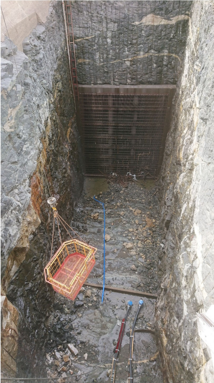
Figur 4. Kurv fra mobilkran senket ned i kraftverksgaten for nå øvre basseng. Bildet er fra 2016, vannstanden var noe høyere i 2021. Foto Roar Sandodden.
