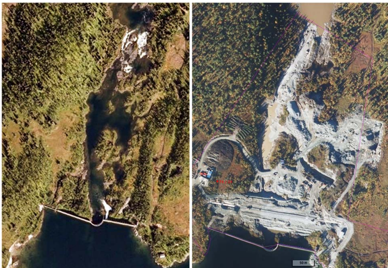
Figur 2. Bildet til venstre er fra 2008 og viser området før den siste utbyggingen, kun med den gamle platedammen mens bildet til høyre er fra 2016, mens anleggsarbeidet pågikk og før den gamle platedammen ble revet.
