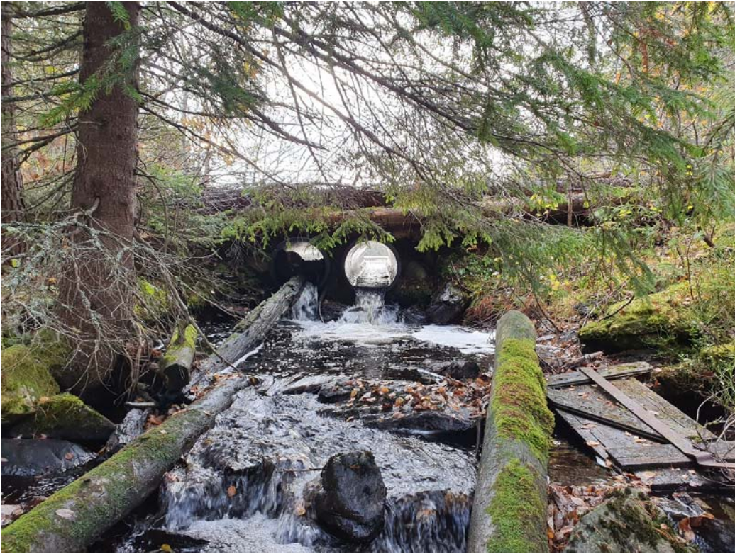
Figur 13. Kulvert gjennom demning ved utløpet av Vulusjøen. Foto: Veterinærinstituttet.
