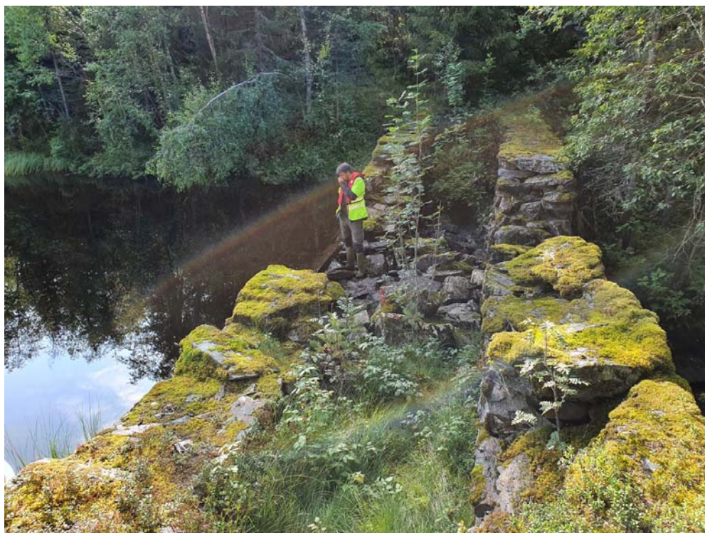
Figur 12. Demning ved utløpet av Oppsjøen. Foto: Veterinærinstituttet.
