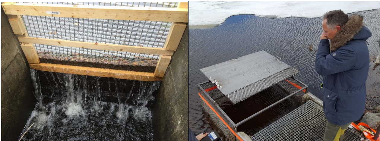
Figur 7. Den første sperra i utløpet (til venstre) ble byttet ut våren 2017 med ei sperre med større gjennomstrømningskapasitet. Foto: Veterinærinstituttet.
